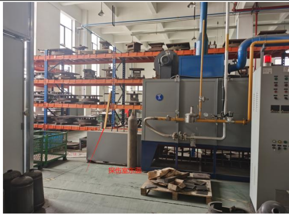
X 光检测室（探伤室）拟建位置东侧（卷盘 车间）
