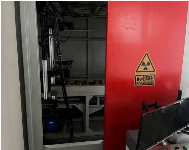
X 光检测室南面（工件工作人员防护门）
